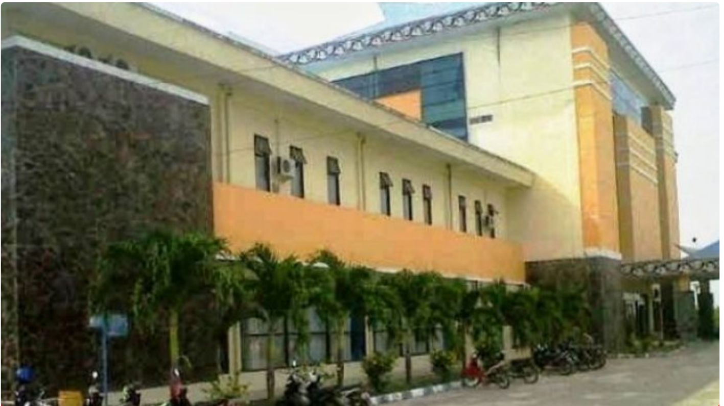
Keterangan Photo : RSUD Perdagangan
